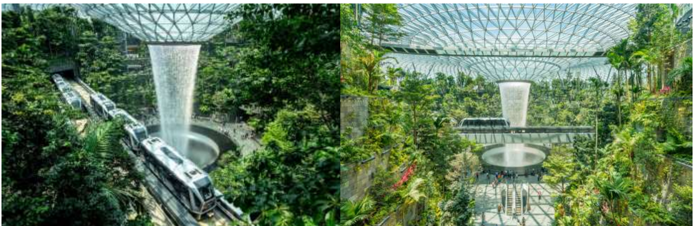
จากเพดาน สู่อ่างน้ำขนาดใหญ่ด้านล่าง
