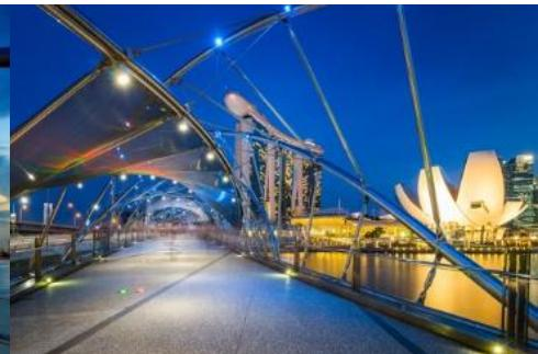
ยังมีความน่าสนใจตั้งแต่ค่อนเข็มของการออกแบบแล้ว คือการใช้เหล็กที่มีลักษณะเป็นท่อ 2 อันที่จะหมุนพนกันไปเรื่อยๆตามความยาวของสะพานที่เสาแนวคิดมากจากรูปแบบของดีอิมนเอ ซึ่งนอกจากความสวยงามแล้วยังช่วยเรื่องการออกแบบโครงสร้างสะพานด้วย
